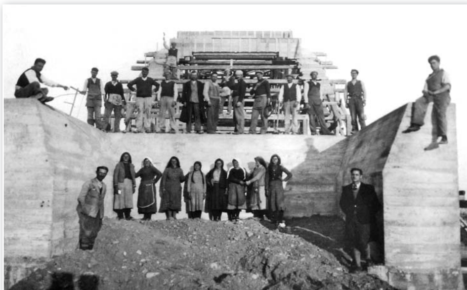
Από την κατασκευή της γέφυρας Μόρνου. (Αρχείο Γ. Παπαθανασίου)
